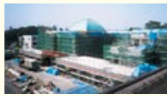
建設中のパルティ
